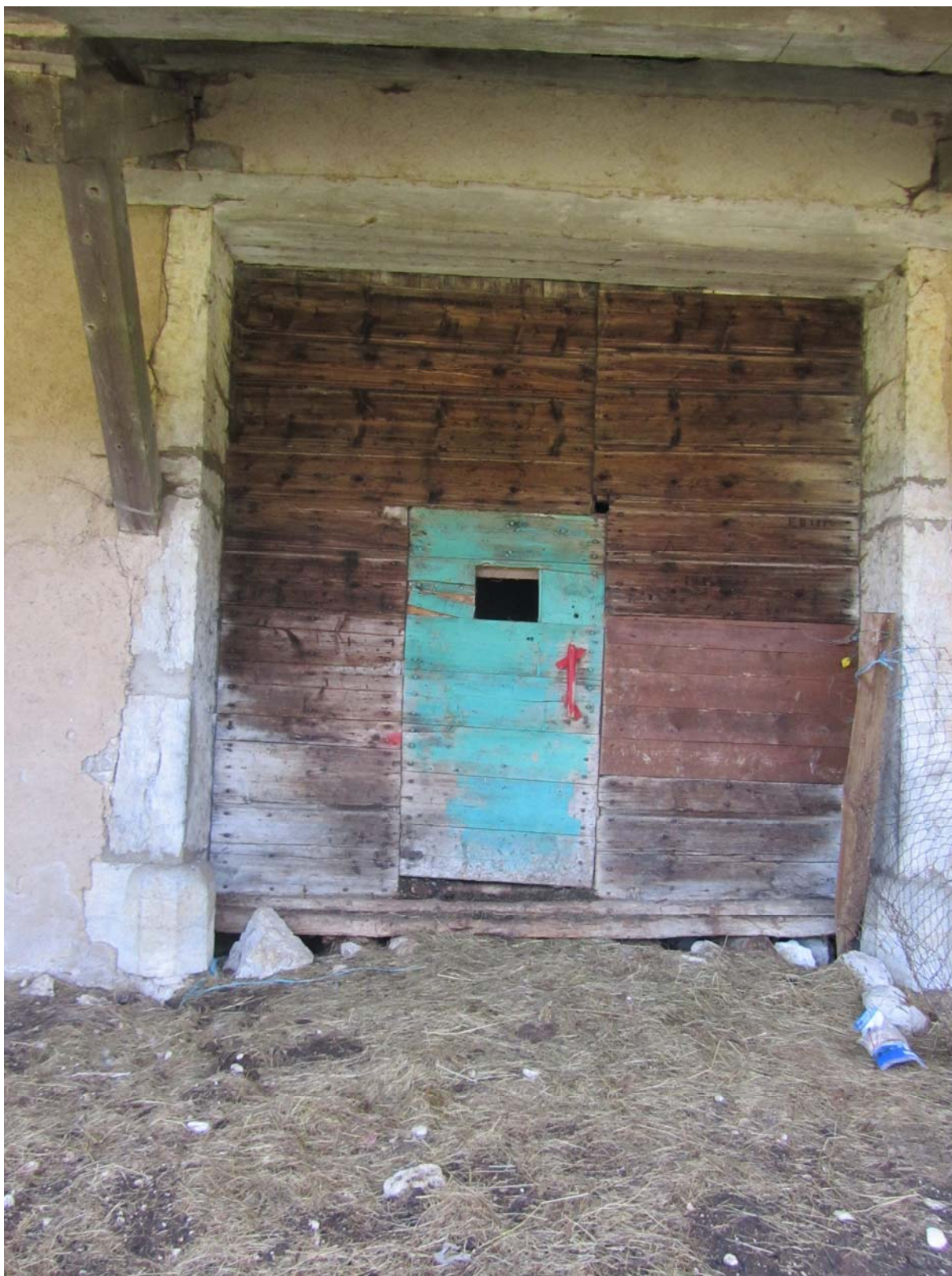
Porte de grange dans la façade nord.
