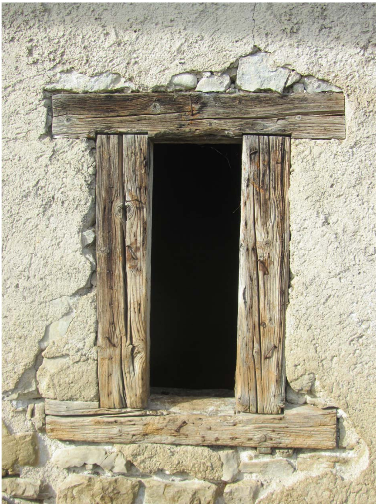
Retour à la façade sud, avec un encadrement de fenêtre à la mode d'autrefois.
